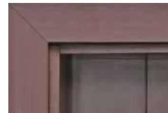
Listwa opaskowa szer. 8cm, cięta pod kątem 45 stopni
