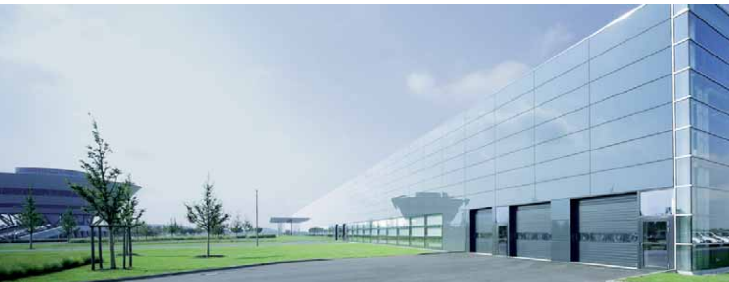
Fabryka montażowa Porsche w Lipsku, w której zastosowano produkty Hörmann
