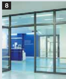
8 Przeciwpżarowe i dymoszczelne konstrukcje z profili zamkniętych
